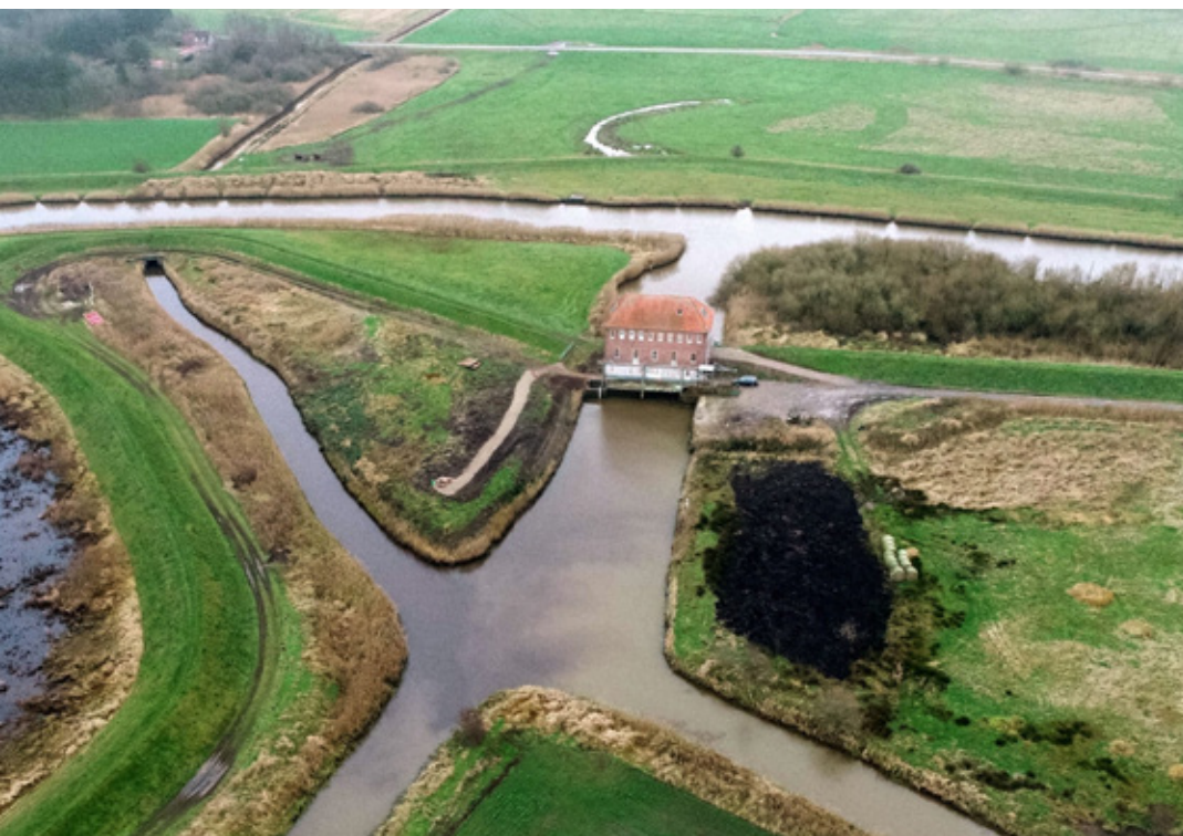
▲ Uden de fire pumpestationer ville Tøndermarsken hurtigt blive oversvømmet. Lægan er den største og åben for offentligheden. Foto: Ulrik Pedersen // Ohne die vier Pumpwerke würde die Tøndermarsch schnell überflutet werden. Das Pumpwerk Lægan ist das größte der Pumpwerke und für die Öffentlichkeit zugänglich // Without the four pumping stations, Tønder Marsh would quickly flood. Lægan is the biggest of them all and is open to the public
